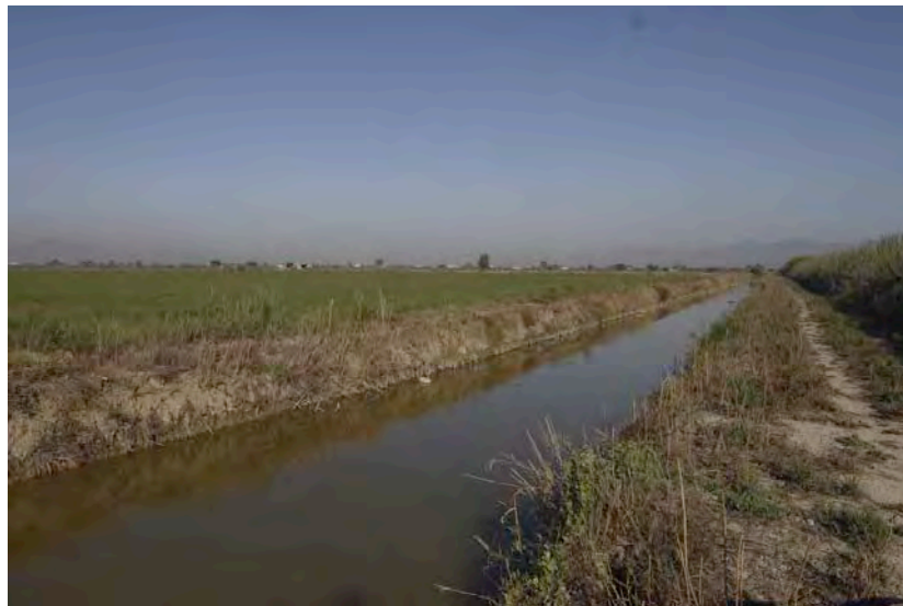
Azarbe de Mayayo donde se pretende construir 2.700 viviendas
