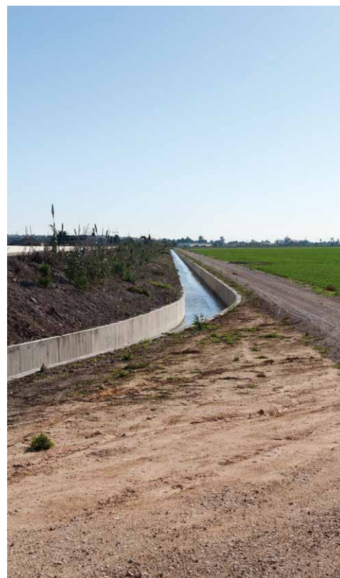
Azarbe de Culebrina antes y después de ser cementado su cauce (S. Arroyo)
