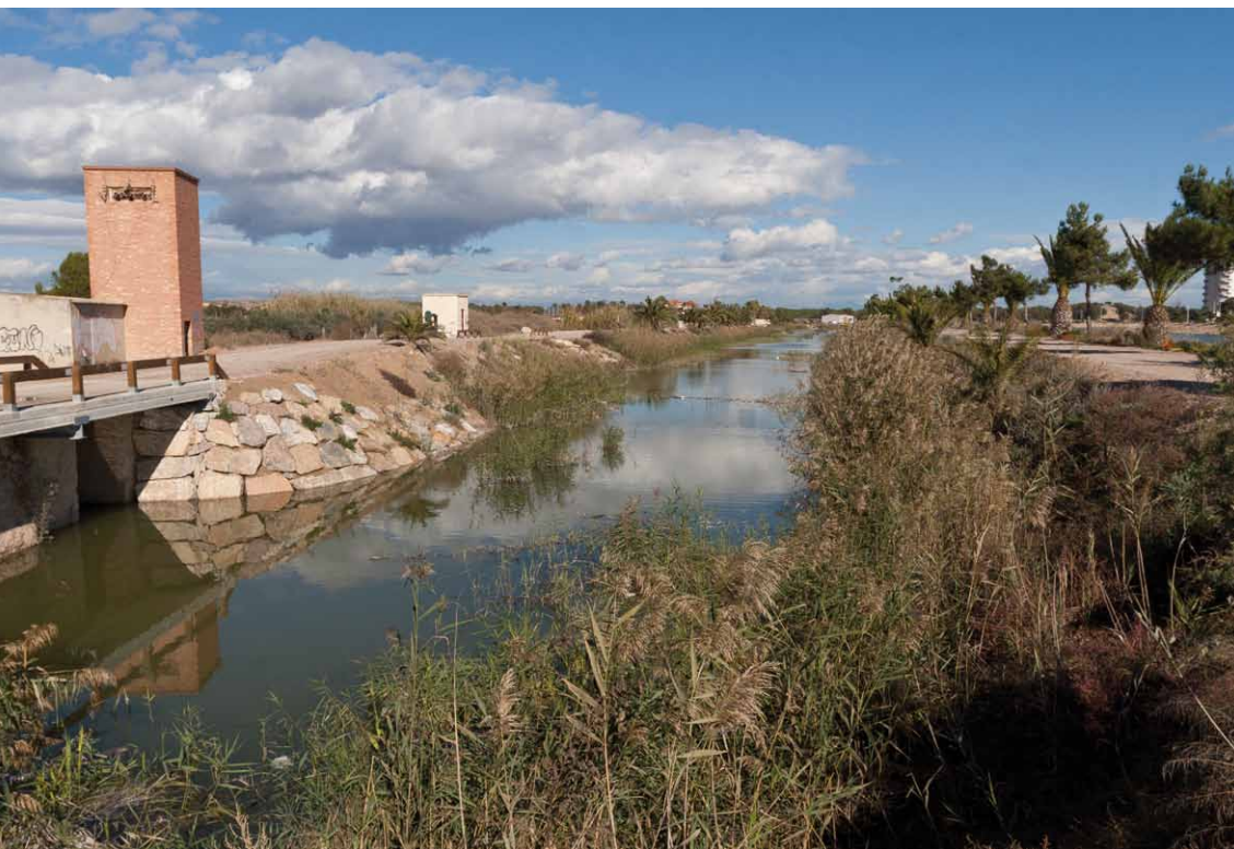
Meandro del cauce antiguo del río Segura en su desembocadura. En los años 90 se realizó un nuevo cauce mucho mas ancho para prevenir inundaciones. (S. Arroyo)
