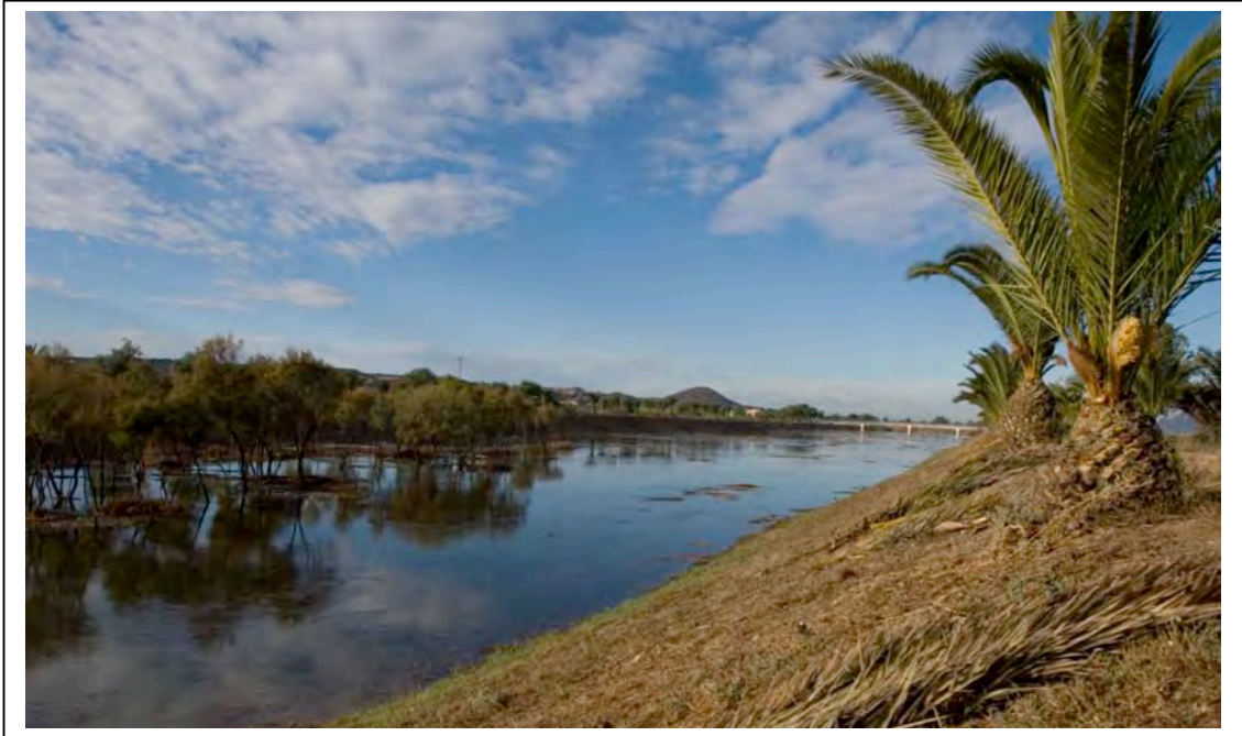
Cauce nuevo aguas arriba de la N-332, durante una crecida del río
