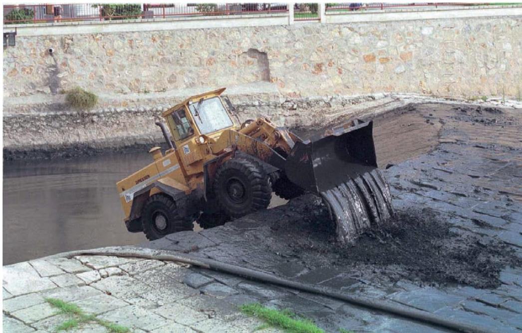
*Extracción de lodos contaminados en el río Segura en Rojales (E. de Gea )*
