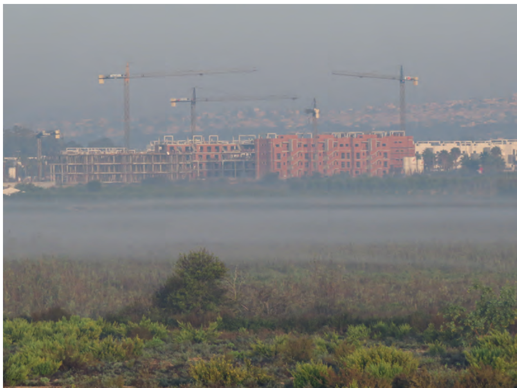
Urbanización del Raso, laguna de La Mata (S. Arroyo)
