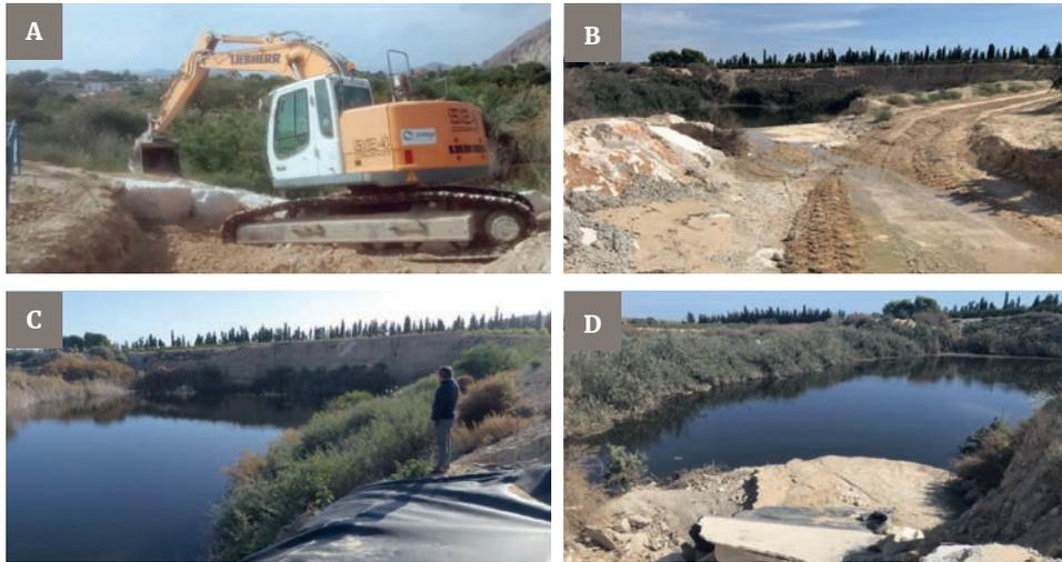
**A** Colocación de grandes rocas de contención (Diego Moya), 2016. **B** Parapeto de rocas hormigonadas y aliviadero hacia la laguna, 2018. **C** Aliviadero en su disposición original y sedimentos acumulándose debajo, 2018. **D** Colapso del aliviadero y del parapeto de rocas 2019.
